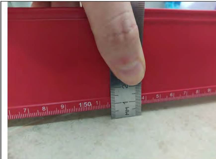
Фото №16. Измерения уровня напольного покрытия в ванной комнате (керамическая плитка).
