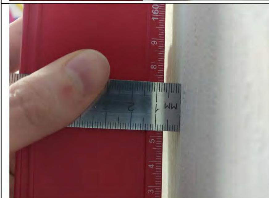
Фото №8. Измерения уровня стен в спальне.
