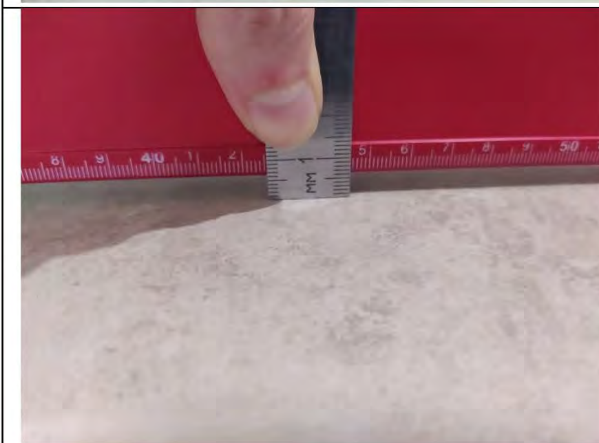
Фото №17. Измерения уровня напольного покрытия в прихожей (керамическая плитка).
