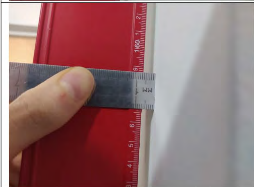
Фото №12. Измерения уровня стен в ванной комнате.
