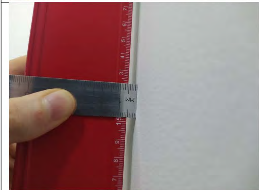
Фото №11. Измерения уровня стен в санузле.
